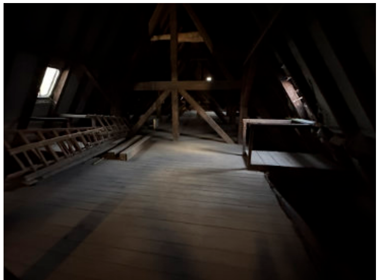
Dachstuhl Kirchenschiff nach der Reinigung
